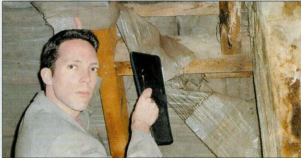
Viele Vermieter ärgern sich über den schlechten Zustand der Wohnung. Foto: Archiv
